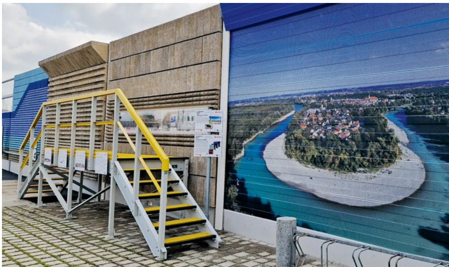
Abb. 7: GFK-Podest mit Treppen und Geländer
