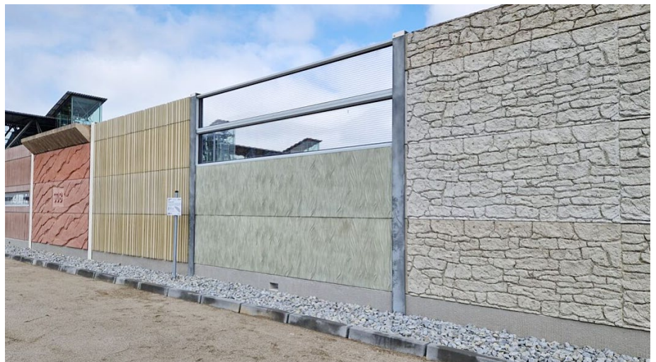
Abb. 3: Verschiedene Betonoberflächen, die mittels Matrixtechnik hergestellt wurden
