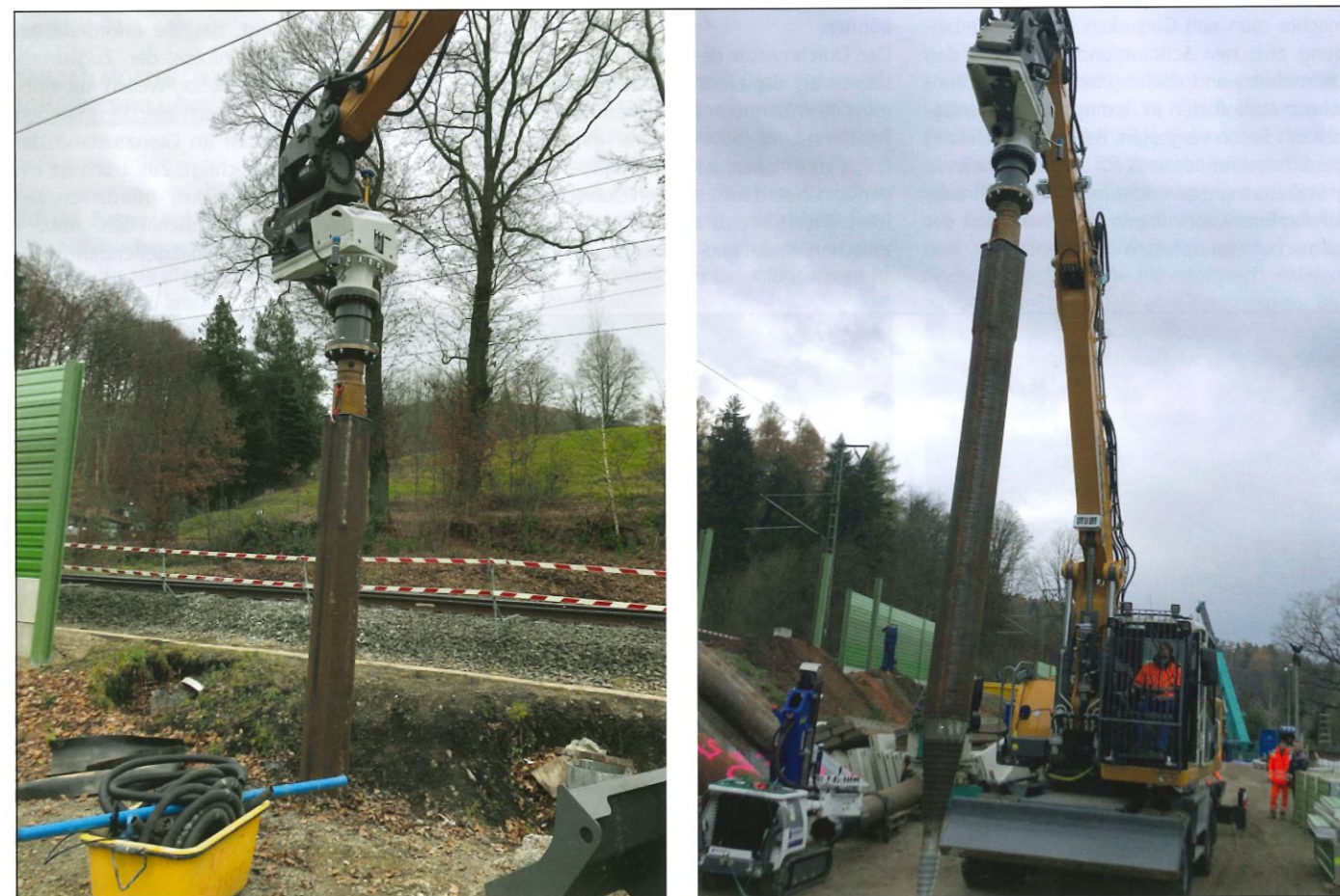
Abb. 5: Testeinbau der Schraubfundamente
