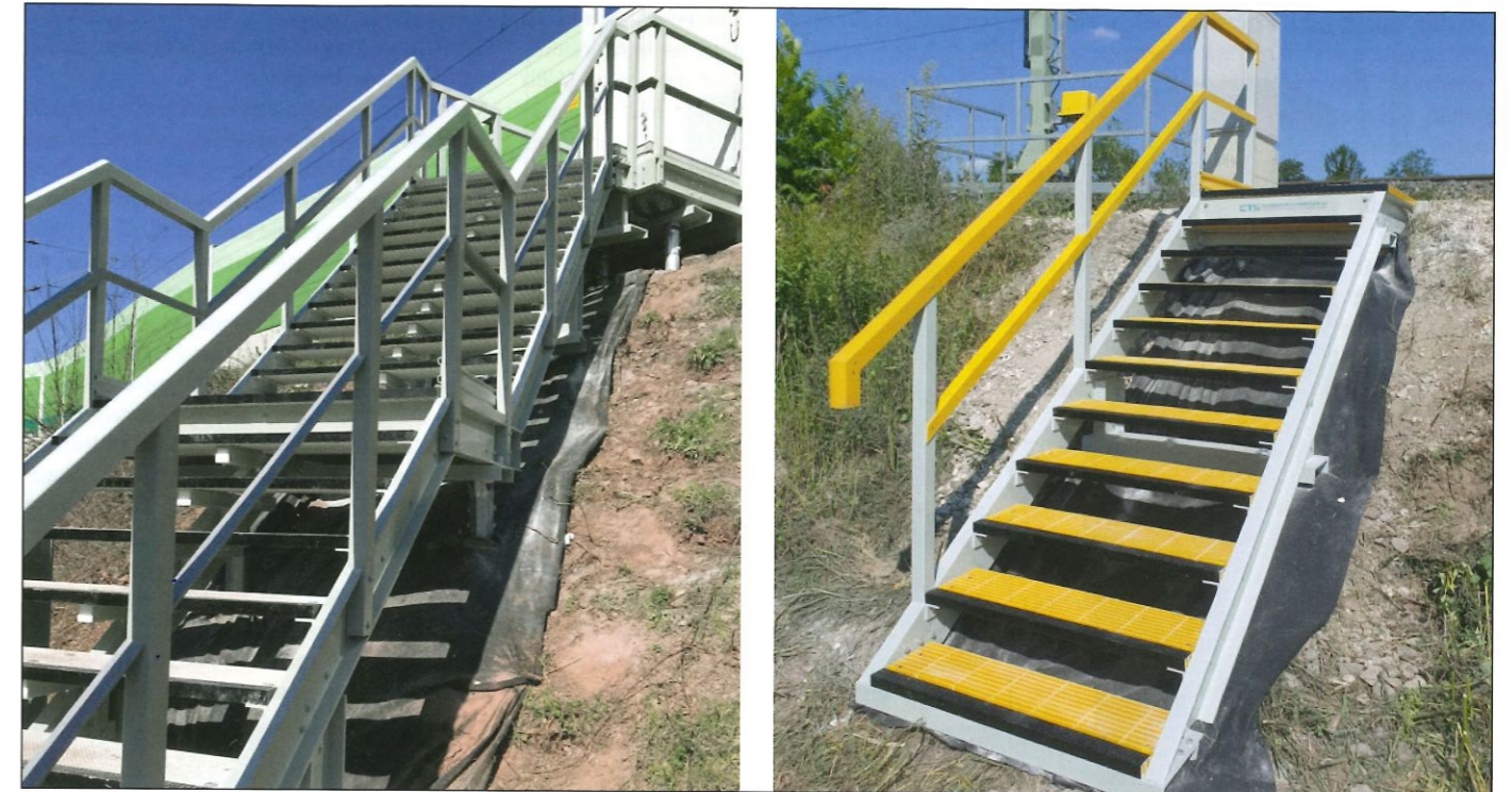
Abb. 2: Böschungstreppe auf Schraubfundamenten gelagert
