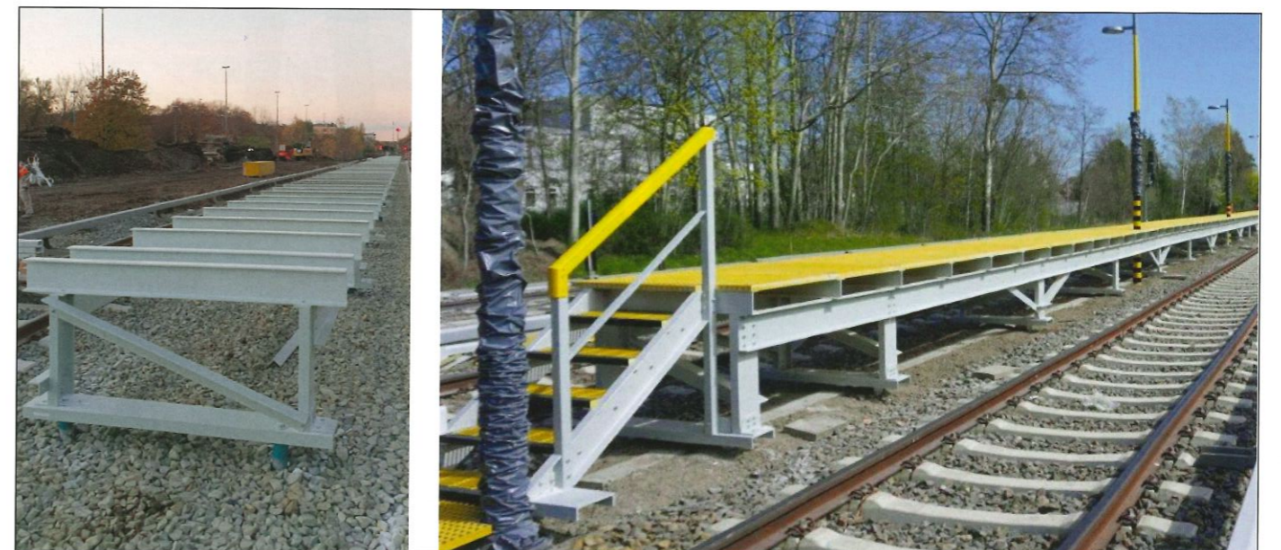
Abb. 3: Podestanlage und temporärer Bahnsteig
